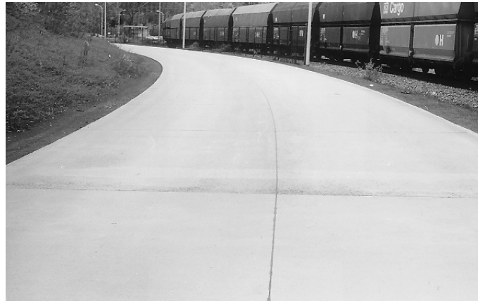
7: Übergang zwischen den Abschnitten ohne (im Vordergrund) und mit Steinkohlenflugasche
