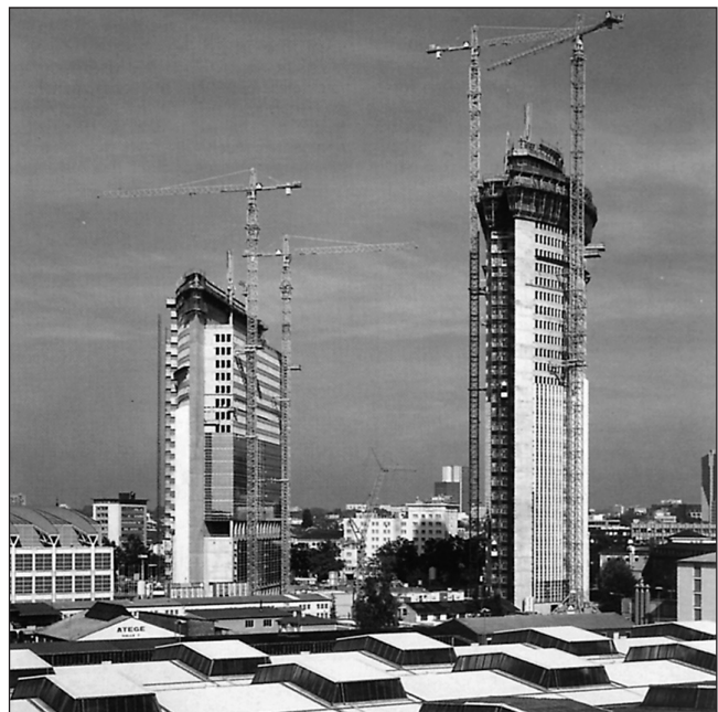
Bild 5: Hochhäuser "Kastor und Pollux" während der Rohbauarbeiten
