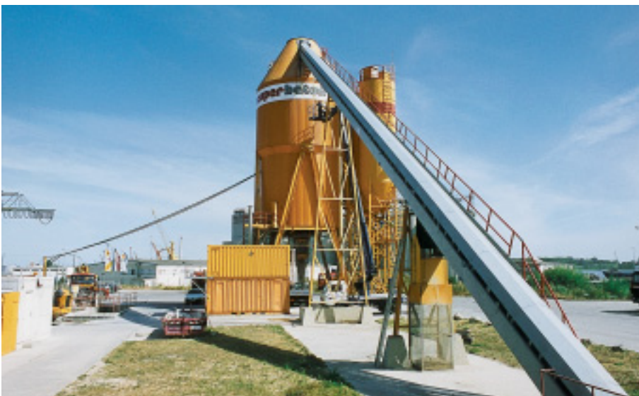
In vielen Bereichen der Bauindustrie ist der Einsatz von Kraftwerksnebenprodukten nicht mehr wegzudenken.
