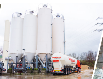
Flugascheanlieferung im Betonwerk
