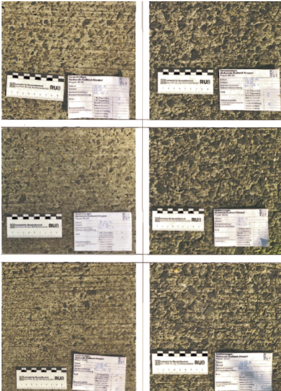
Bild 8: Aufnahmen der Betonstraße im Bereich der Bohrkernentnahmestellen (links: ohne Flugasche; rechts: mit Flugasche)
